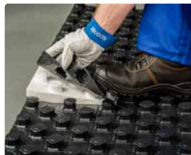
Folia de polistiren vacumat oferă rezistență mecanică suplimentară și etanșare perfectă la umiditate
