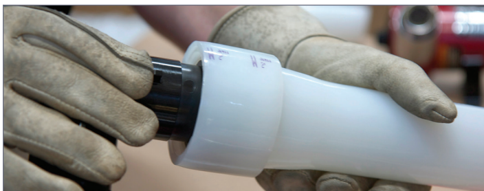
Figura 2-26: Introducir el accesorio
