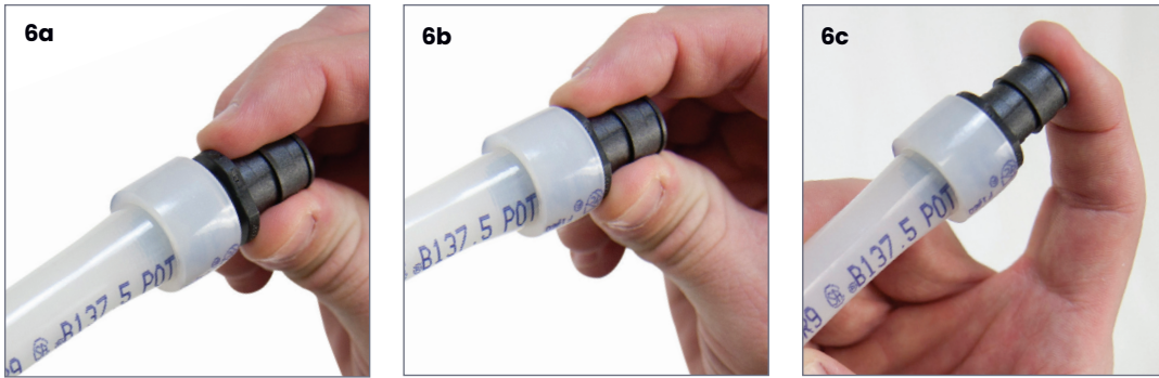
Figura 2-5: Introducción del accesorio ProPEX en la tubería PEX de 1/2" de Uponor
