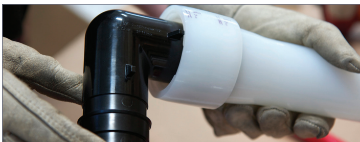
Figura 2-27: Asegurar que la tubería y el anillo se coloquen contra el hombro del accesorio
