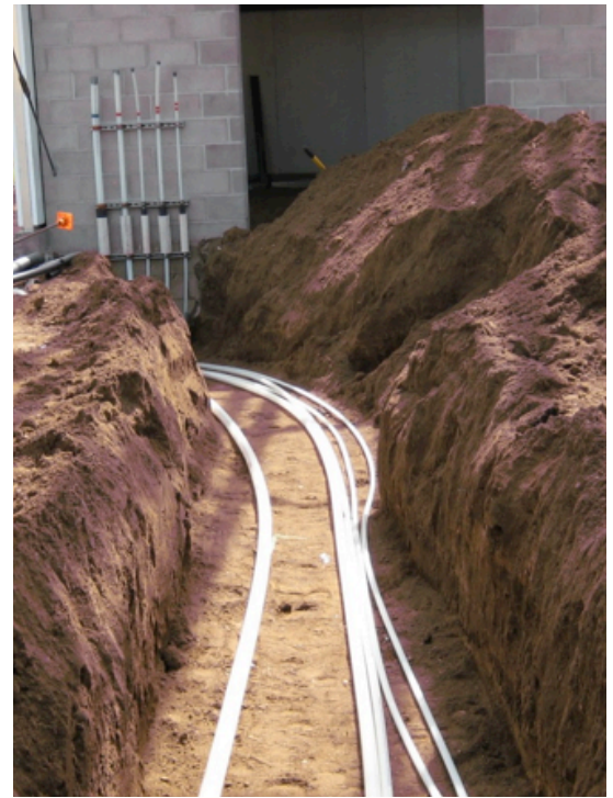
Figura 6-23: PEX de Uponor bajo el nivel del suelo
