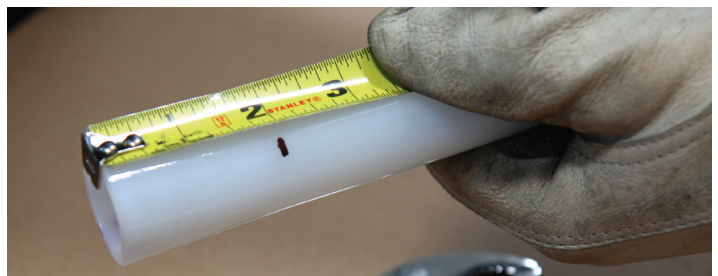
Figura 2-38: Medir desde el extremo del tubo
