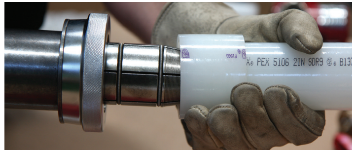
Figura 2-22: Deslizar el cabezal en la tubería
