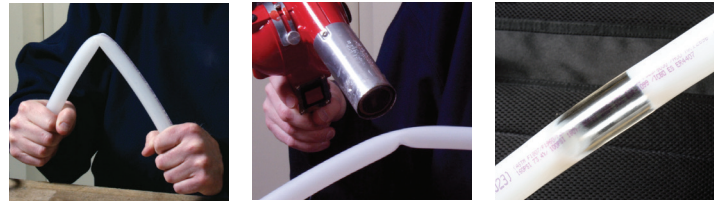
Figura 6-1: Reformar tubería torcida
