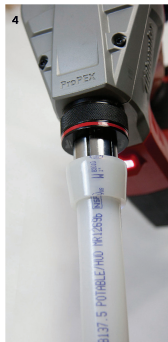
Figura 2-9: Expansión con la herramienta expansora ProPEX M18 de Milwaukee
