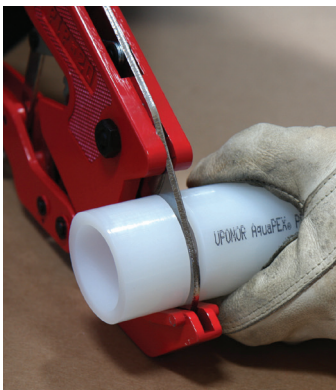
Figura 2-20: Cortar la tubería
