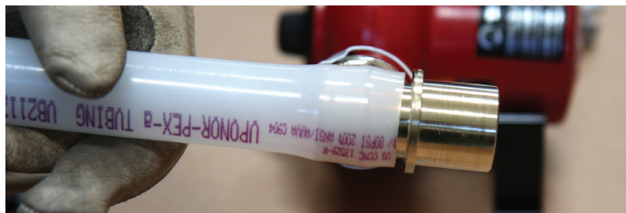
Figura 2-35: Calentar la conexión
