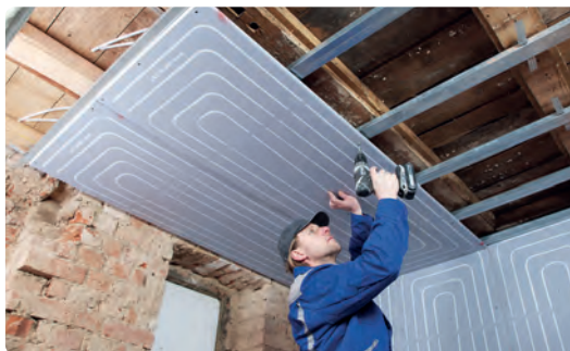
Si una vivienda o edificio está vacío, en el momento de realizar una rehabilitación total, ésta puede realizarse en un sola etapa de instalación
