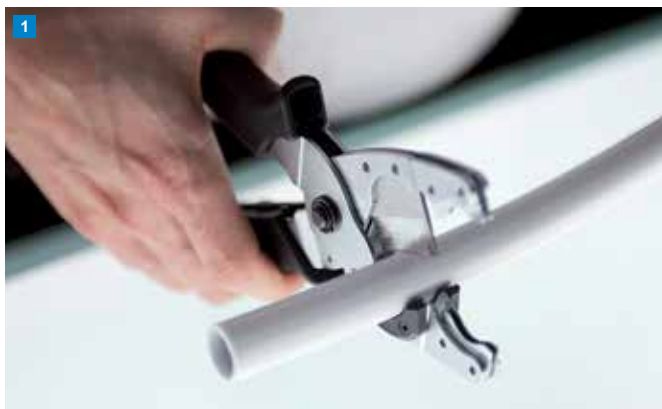
Odrez cevi Najprej se ravno in pravokotno odreže cev z uporabo Uponorjevih škarij.
