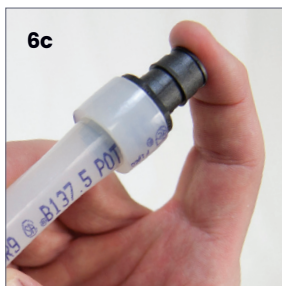
Figura 5: Introducción del accesorio ProPEX en la tubería PEX de 1/2" de Uponor
