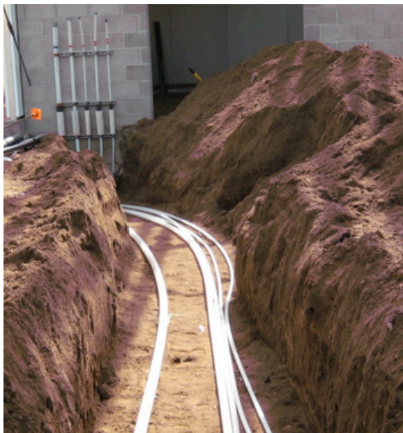
Figura 80: PEX de Uponor bajo el nivel del suelo
