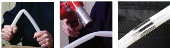
Figura 43: Reformar tubería torcida
