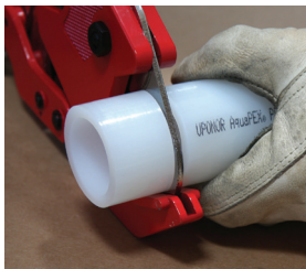
Figura 20: Cortar la tubería
