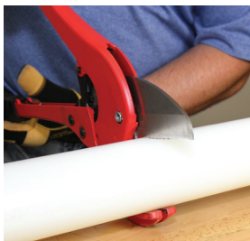
Figura 14: Cortar la tubería
