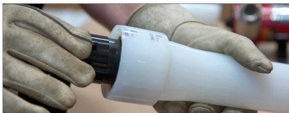
Figura 26: Introducir el accesorio
