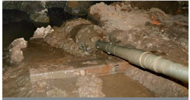
Fot. 15. Koniec instalacji ostatniej rury za rozwiertakiem barytkowym.
