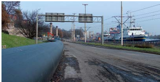
Fot. 6. Koniec rury PE 1033 wyłożony na ulicy Jana z Kolna, podczas wciągania w otwór pod Odrą
