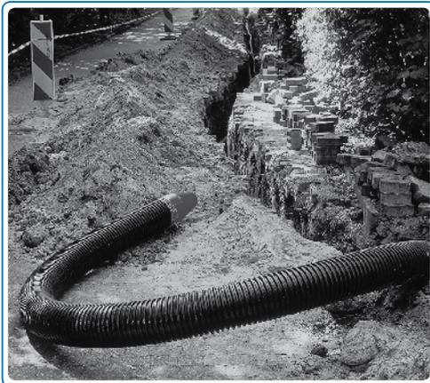
La especificación indica un lecho de arena sin piedras. El tamaño del grano de arena será de entre 0 y 2/3 mm. No se deben incluir nunca en la zanja objetos puntiagudos o con bordes cortantes. Para garantizar la duración del tubo envolvente es fundamental preparar cuidadosamente el lecho del tubo (al menos 10 cm
