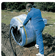
Dostawa zgodna z przedmiarem i rozkładanie prosto ze zwoju.
