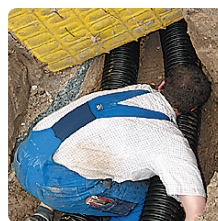
Elastyczne i szybkie przekładanie przez mury w celu połączenia z rozdzielaczem.
