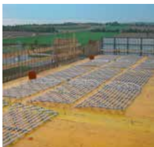
Ukladania vopred pripravených modulov Contec ON na debnenie podľa projektu.
