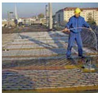
Alternatíva: Namotávanie potrubí Uponor PE-Xa do prázdnych modulov Contec ON na stavbe.
