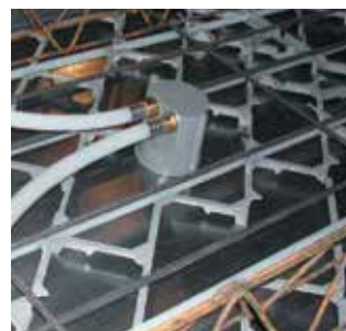
Integrácia Energetickej zásuvky Contec T2 do betónu.
