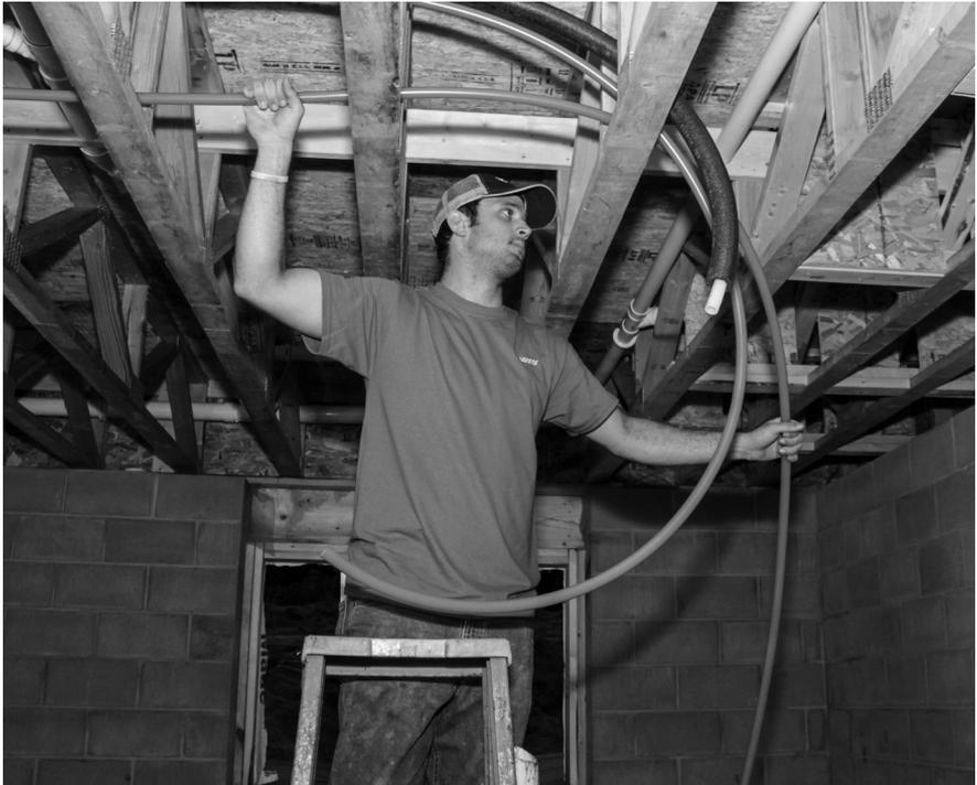
Figure 5-1 : Installation de canalisations Uponor AquaPEX dans des poutrelles ajourées
