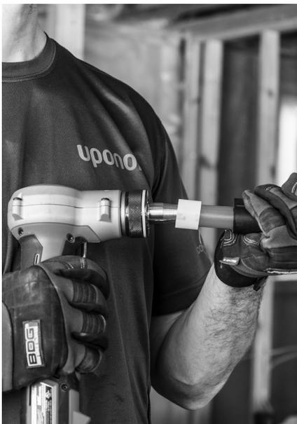
**Figure 3-5 :** Effectuer un raccordement ProPEX
