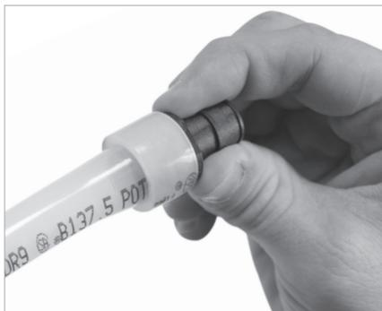
Figure 3-14 : Insérer le raccord
