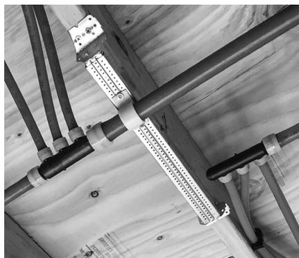
**Figure 5-9 : Installation de tés multivoies**
