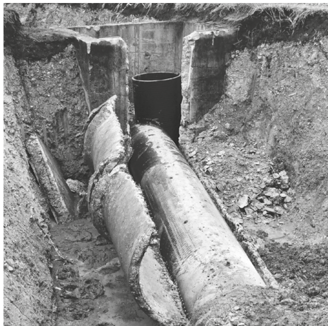
Komora studzienna \varnothing 1000 została zastąpiona nową studzienką Weho
