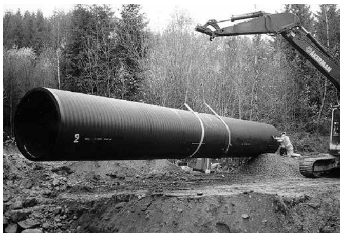
Rys. 13.1.a. Typowy Przepust Weholite pod drogą
