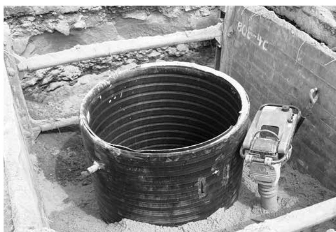
Rys. 12.1.b. Schemat posadowienia w gruncie nawodnionym – do obliczeń siły wyporu studzienek Uponor Infra można wykorzystać program Uponor Infra.
