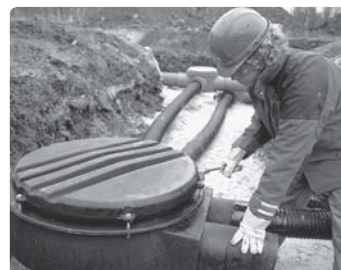
Pokrywę zamknąć i dokręcić śrubami.
