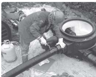
Wyjścia rur osłonowych przeczyszczyć papierem ściernym, oczyścić rury, a następnie uszczelnić za pomocą taśmy termokurczącej.
