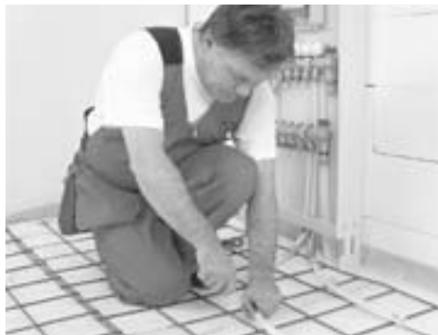
Rys. 31. Przymocuj rurę do siatki za pomocą specjalnych drucików.
