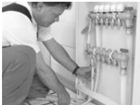
Rys. 39. Montaż pętli grzewczych rozpoczynaj od zasilenia, a kończ na powrocie (wtedy należy obciąć końcówkę rury).
