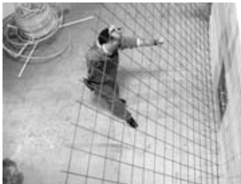
Rys. 30. Ułóż siatkę metalową.
