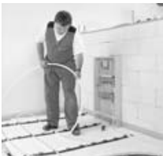
Rys. 34. Zamontuj pętlę grzejną wciskając ją w mocowania szyny montażowej.
