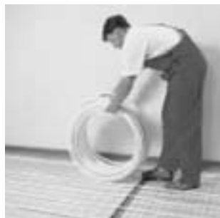
Rys. 34. Zamontuj pętlę grzejną wciskając ją w mocowania szyny montażowej.
