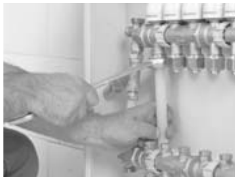
Rys. 40. Dokręć mocno nakrętki.
